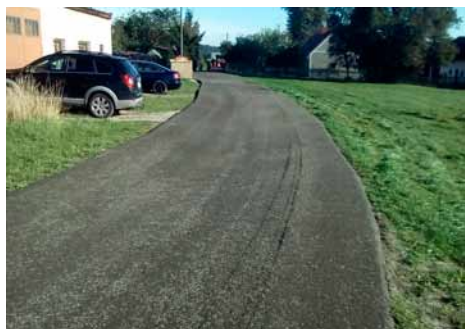
Oprava MK Ke kovárně – Bělečko
