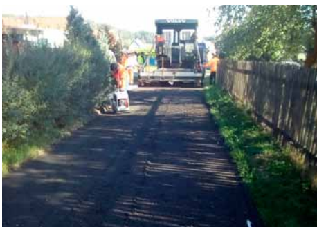
Oprava MK Ke kovárně – Bělečko
