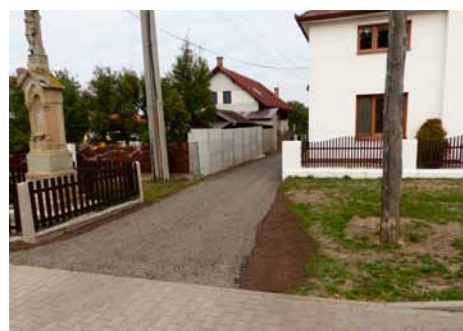
Oprava MK U zvoničky – Hrachoviště
