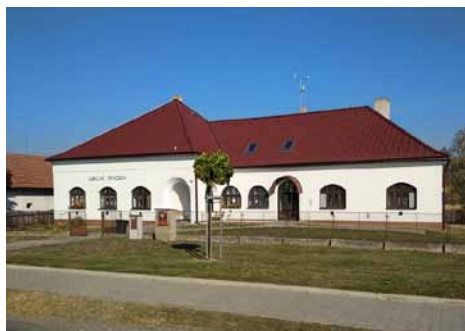
Výměna střešní krytiny DPS Hrachoviště
