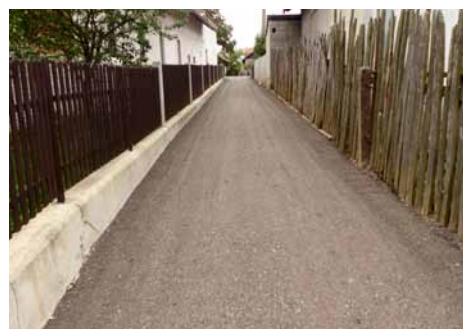
Oprava MK U zvoničky – Hrachoviště
