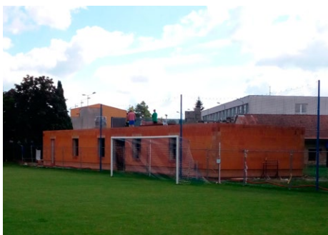
Probíhající stavba kabin na fotbalovém hřišti v Býšti
