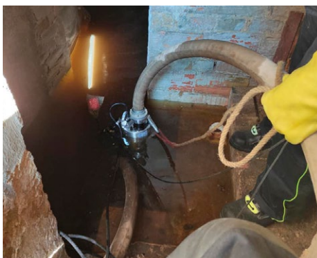
Čerpání vody ze zatopeného sklepa
