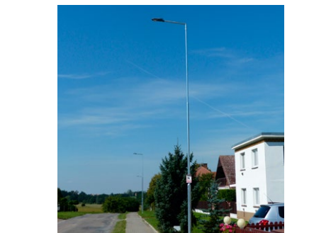
Modernizace veřejného osvětlení v Hrachovišti
