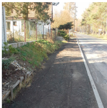
Dešťová kanalizace v Bělčce – po
