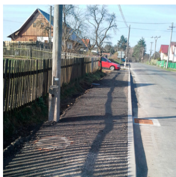
Dešťová kanalizace v Bělčce – po
