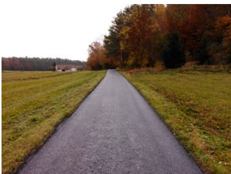
Rekonstrukce silnice Hoděšovice
