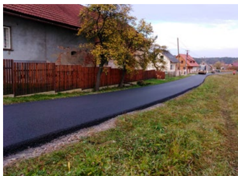
Rekonstrukce silnice Hoděšovice
