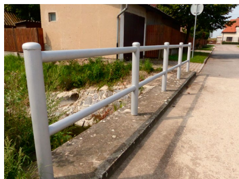
Natřené zábradlí mostků v Býšti
