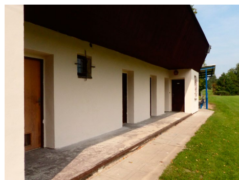
Oprava kabin na fotbalovém hřišti v Býšti
